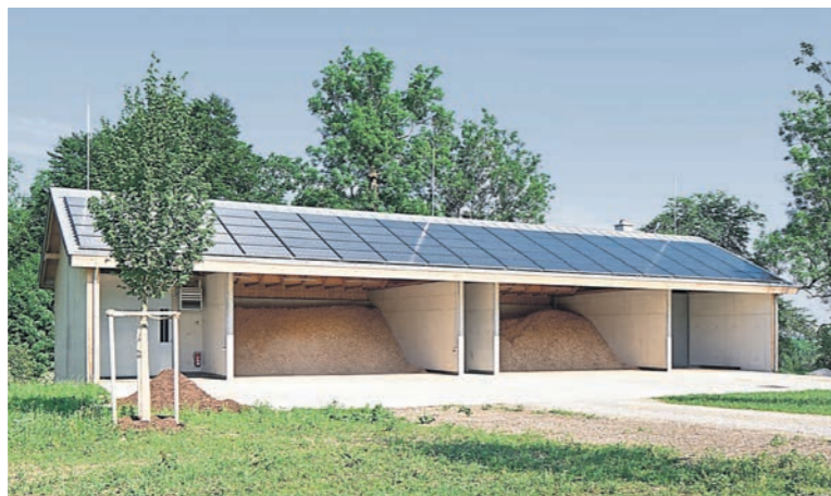
Das „Energiehaus“ mit Hackschnitzellagerung, Blockheizkraftwerk, und Photovoltaik.
